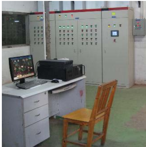
冰蓄冷空调机组 2
